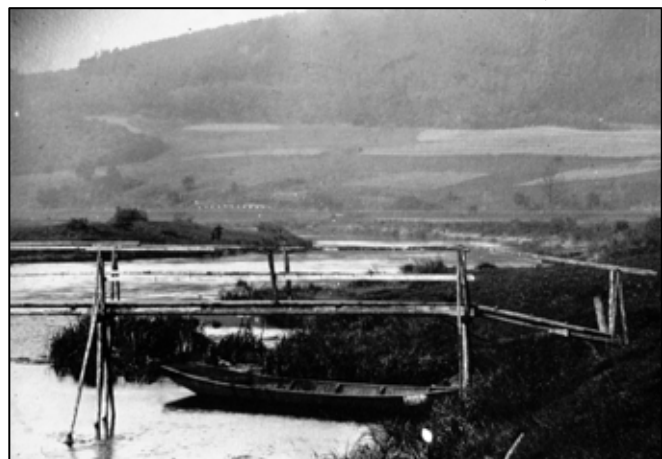
Die Schwarzenberger Spickebrücke und der Fährkahn. Foto: Prack – Repro: Maurer
